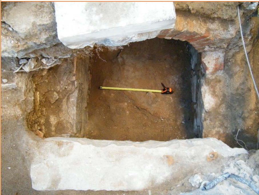
Foto 8. Vista general del col·lector de carrer Carretes.
