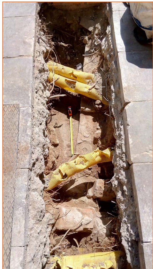
Foto 10. Estructura de desguàs en desús del carrer Sant Pau.
