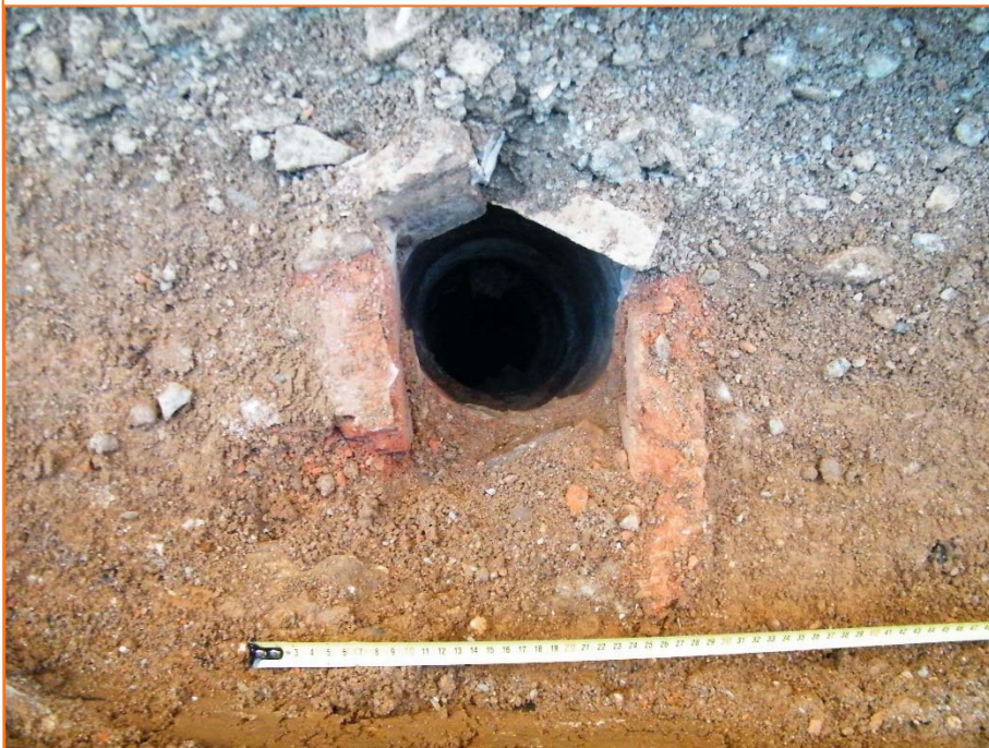
Foto 4. Desguàs ceràmic vertical UE 2.
