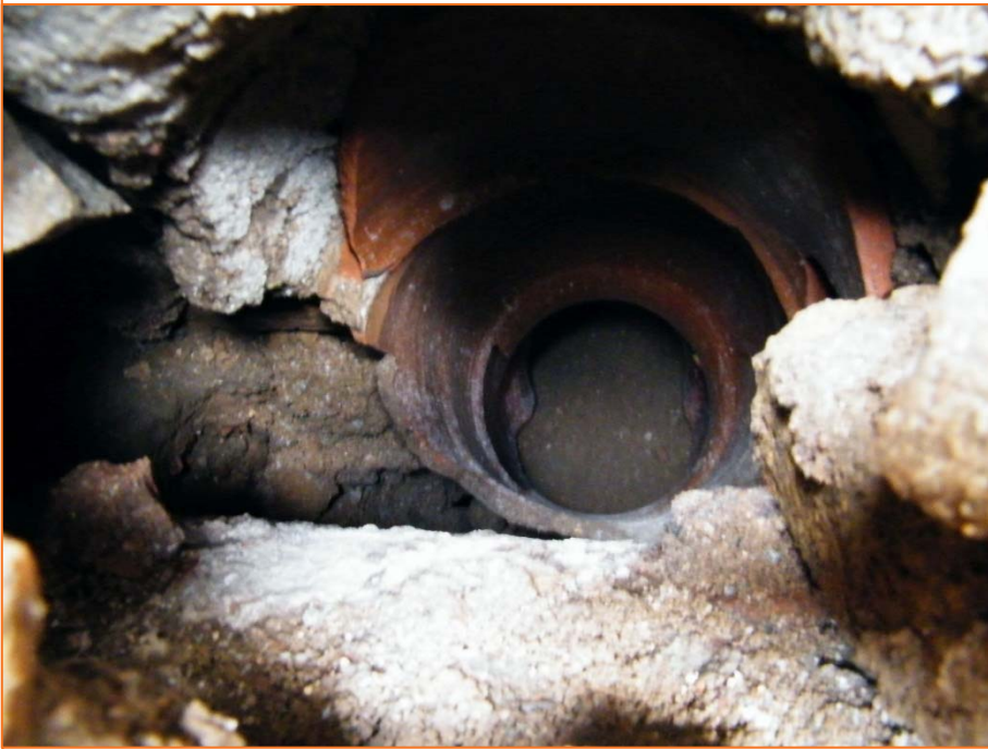
Foto 3. Desguàs ceràmic vertical UE 1.
